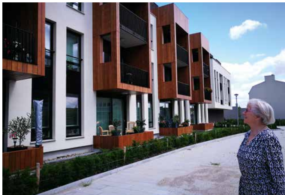
Mevrouw Gulpers voor de nieuwbouw aan de Kampstraat in Landgraaf.
