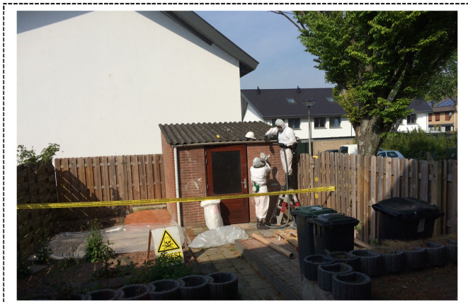
Asbest saneren van het bergingsdak
