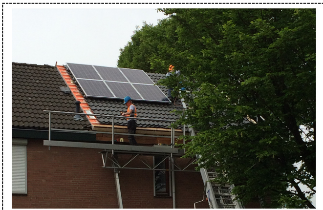
Werkzaamheden aan het dak
