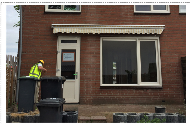
Achtergevel voorzien van nieuwe kozijnen
