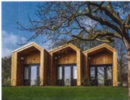
Voorbeeldproject met flexwoningen
